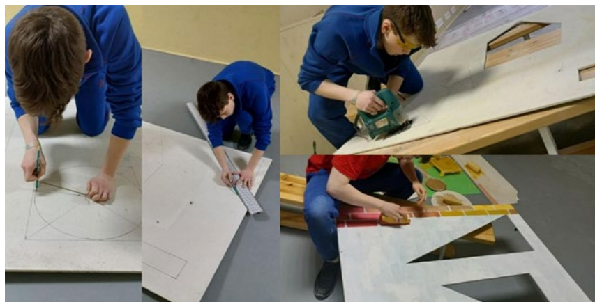
Рисунок 2 – Работа с материалами и оборудованием
